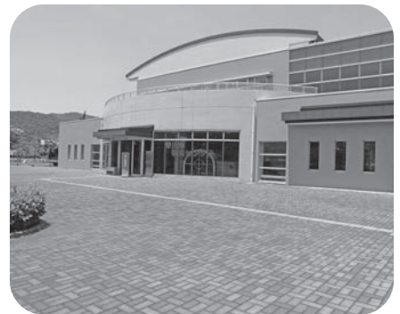
香川県防災センター
