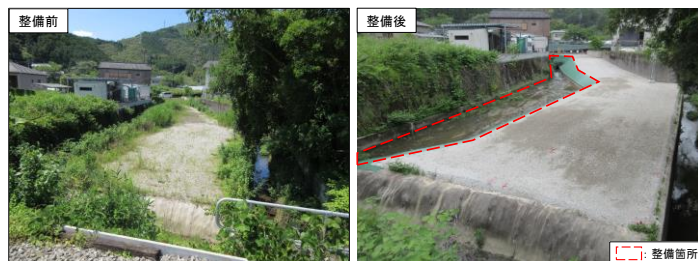
水路の整備（岡花地区）
