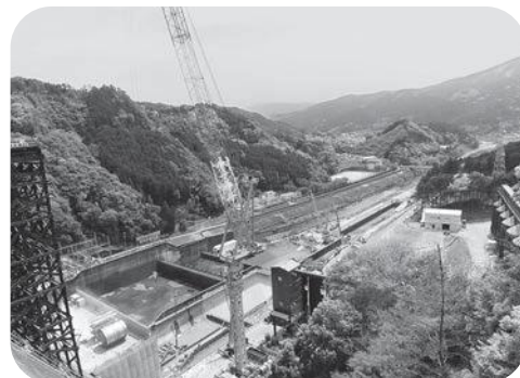
工事現場風景
