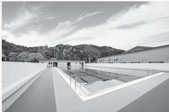
プール完成写真
