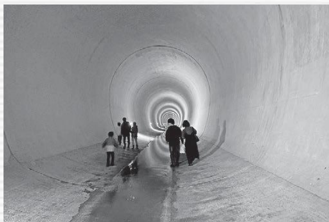
新日下川放水路内見学
