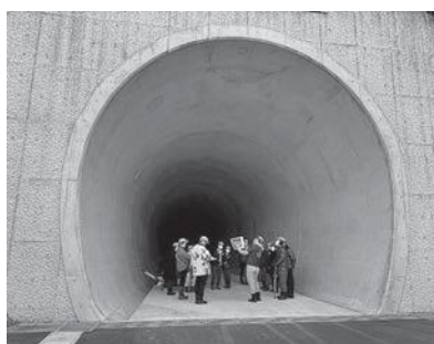
放水路ガイドの様子
