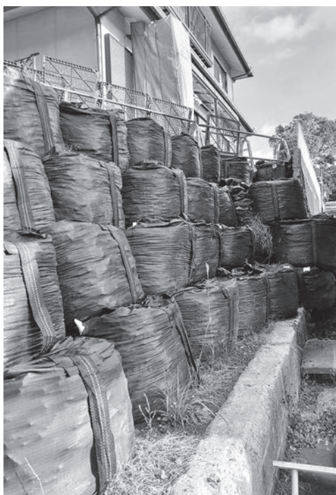
望ヶ丘擁壁崩壊現場
