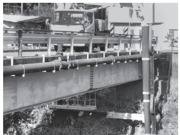
橋梁点検を行っている正岡寺橋
