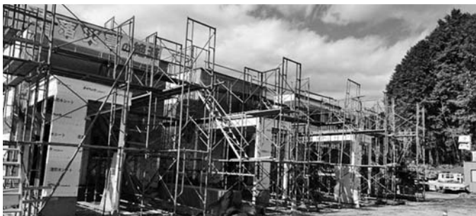
建設中の能津地区地域優良賃貸住宅
