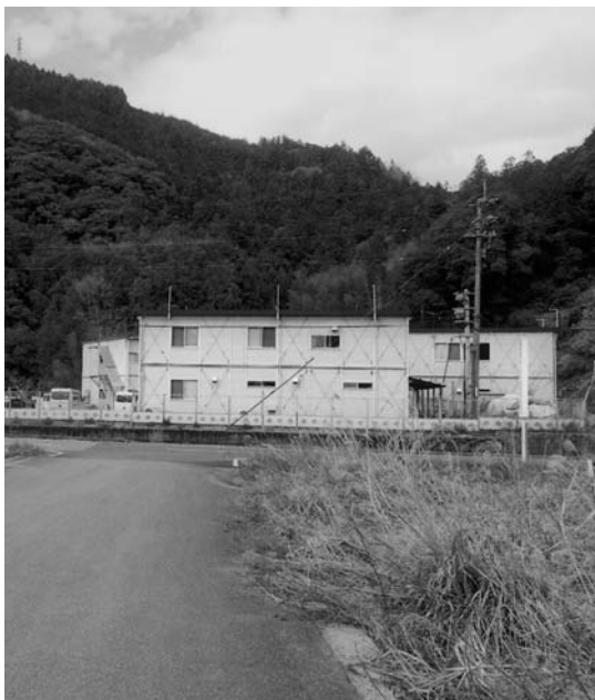
住宅地として適地の放水トンネル工事会社の宿舎
