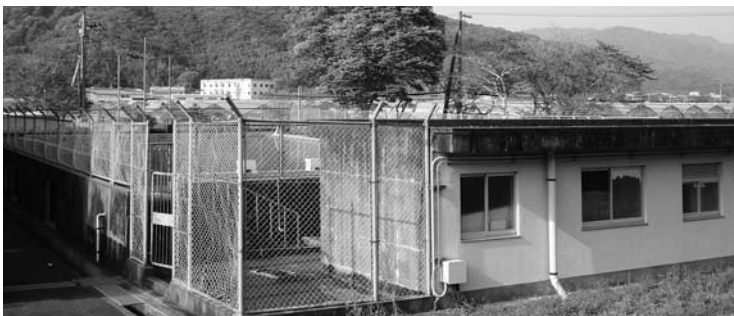
改築予定の日高中学校プール
