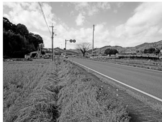
改良工事が進む村道山ノ下西鹿児線と山ノ下観音堂線(国道の左が九頭地区、右が岩目地西地区)
