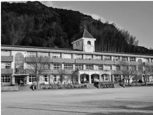
計画的に大規模改修を進める日下小学校
