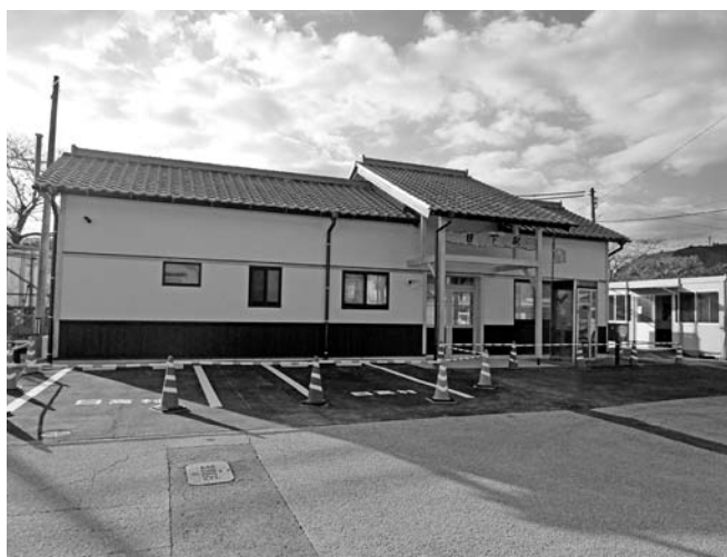
改修された日下駅舎
