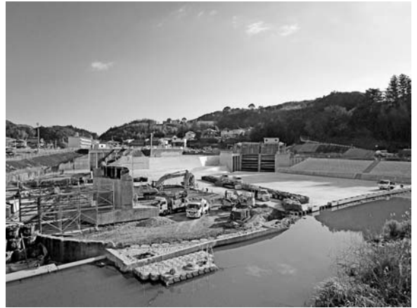
令和6年4月に完成式典が行われる新日下川放水水路の現況
