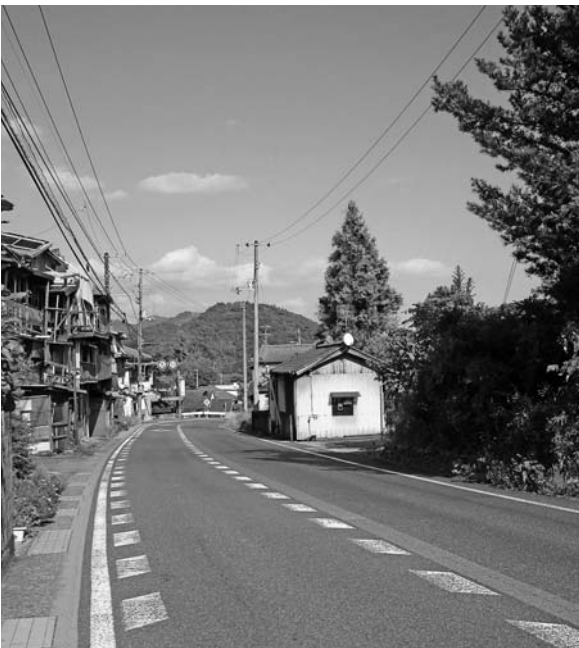
事故が再三発生し改良を望む折月坂カーブ
