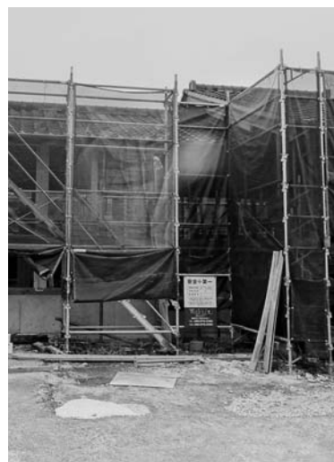
改修工事が進む 日下駅舎
