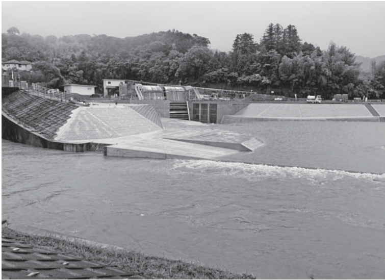
運用を始めた新日下川放水路の状況(台風2号の影響による豪雨)
