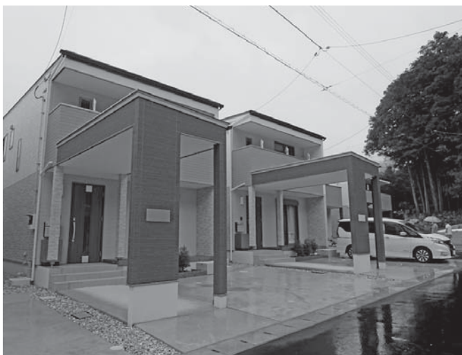
7戸のうち6戸の入居者が決まった「のうづ夢団地」
