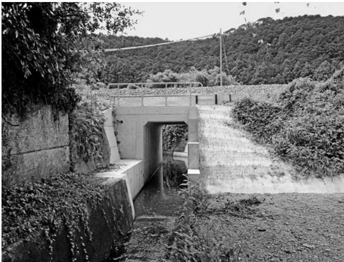
J R 日下岡花間鉄道下排水路工事
