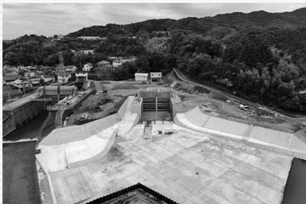
通水前の新日下川放水路呑口部 6月1日(木)現在
