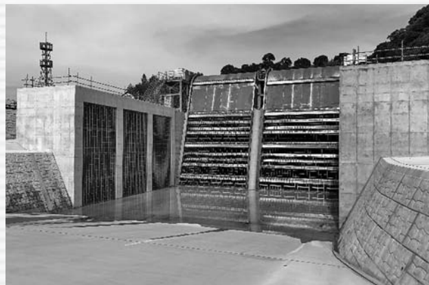
新日下川放水路に設置された除塵機
