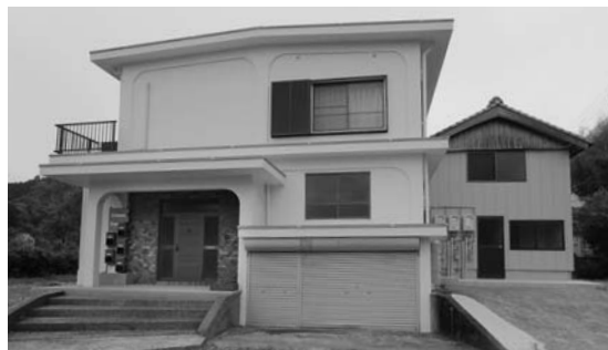
完成したシェアハウス
