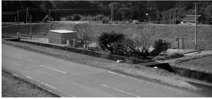
江尻第2水源地の取水ポンプ
