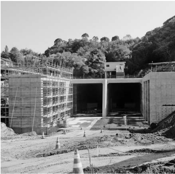
令和5年完成を目指す新規放水路(呑口側)
