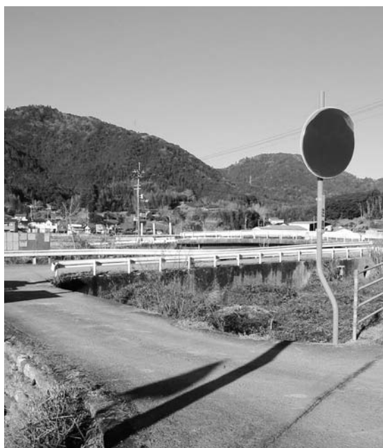
転落防止柵の設置を望む九頭地区から加茂小中学校への通学路途中
