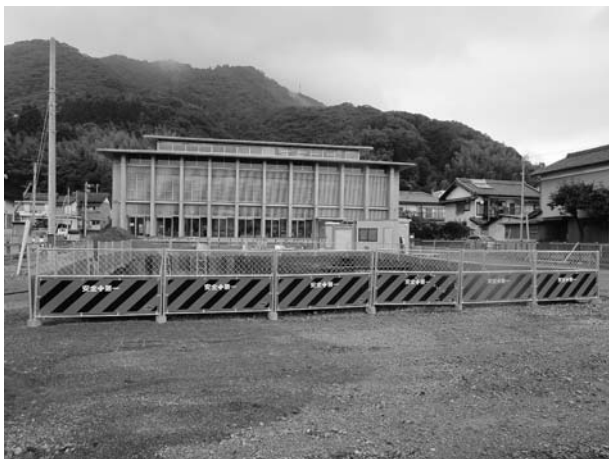
役場前貯水槽・防火水槽工事
