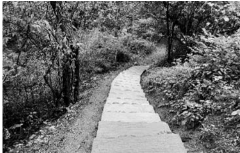
完成した遊歩道
