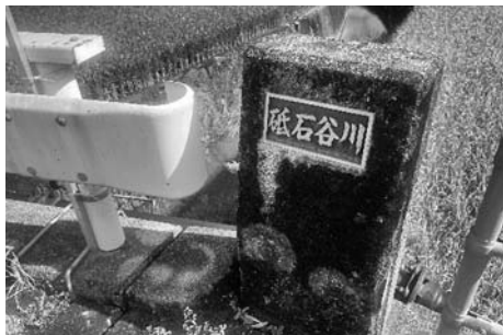
県道に架かる橋の銘板
