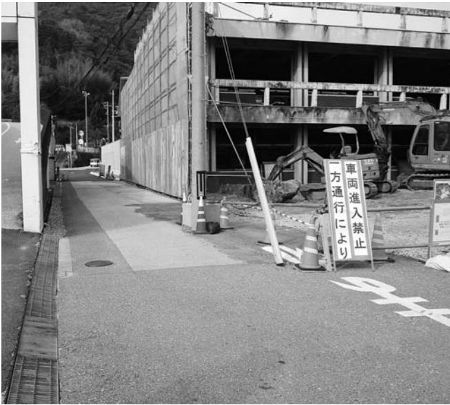
一方通行での通行が可能となった 役場庁舎西側道路
