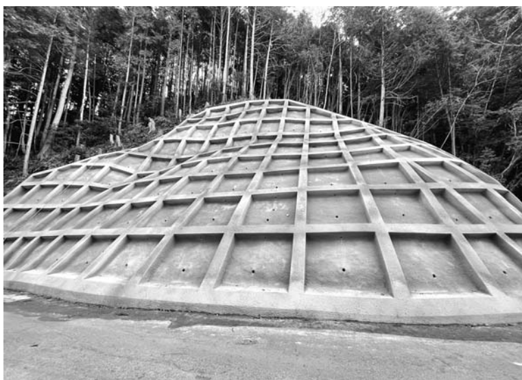
鴨地谷口地区復旧工事が完了
