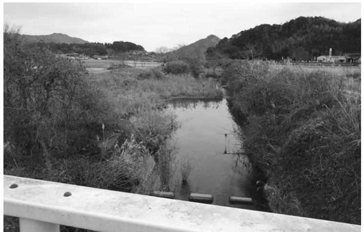
堤防のかさ上げと川床の掘削工事が予定されている六所橋からの下流部
