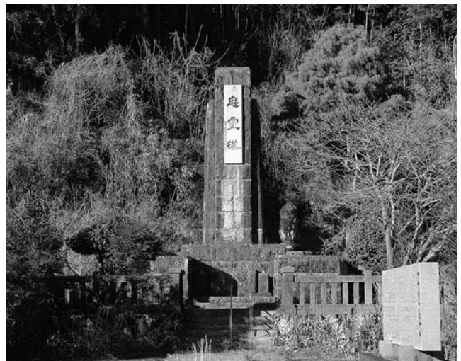
耐震検査を予定している日下忠霊塔
