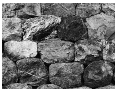
川石を加工したと思われる石積(小村 武山家)
