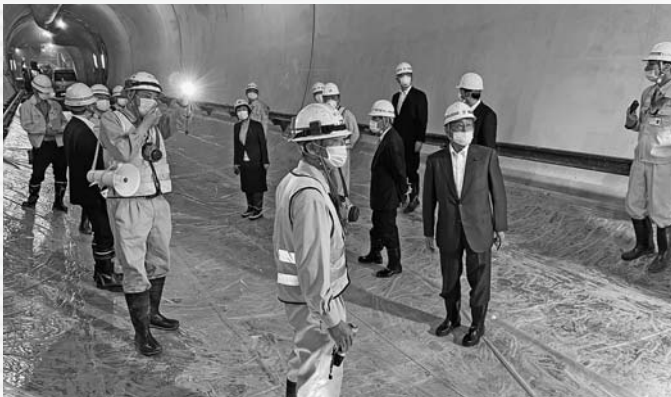
現地見学会(工事概要説明)
