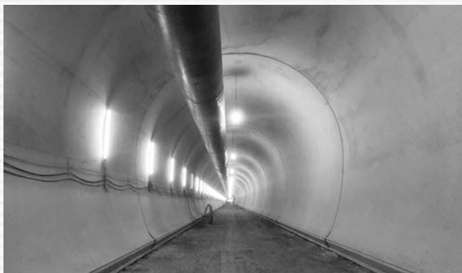
日下川新規放水路(呑口側)進捗状況
