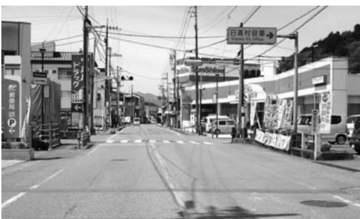
歩道整備が待たれる国道
