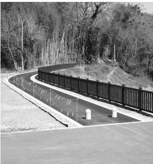
完成が待たれる江尻地区親水公園 (完成した遊歩道)
