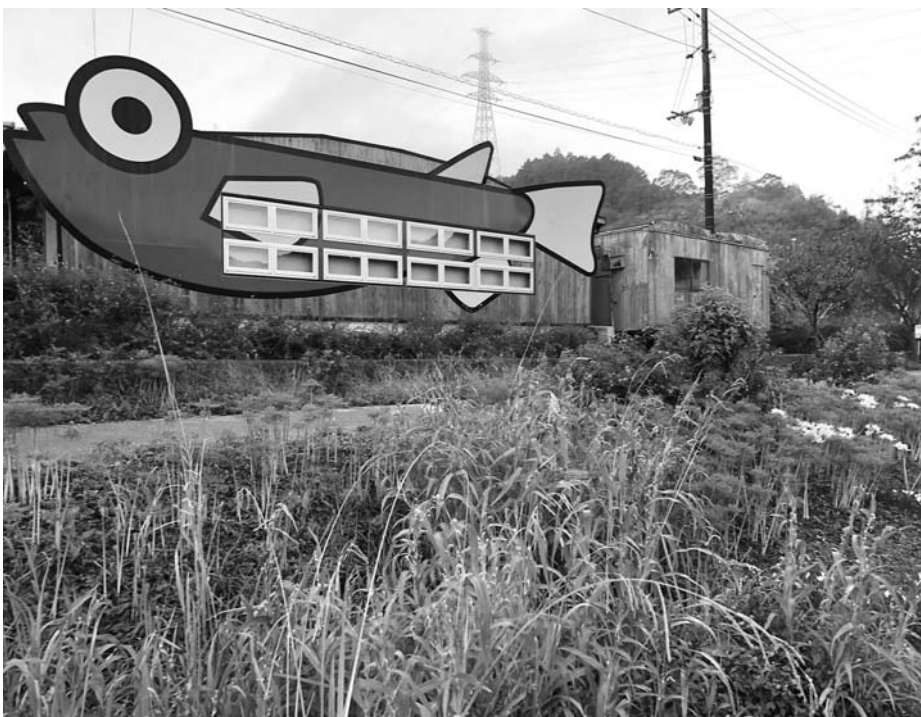
改修工事が完成した「めだかさん家」
