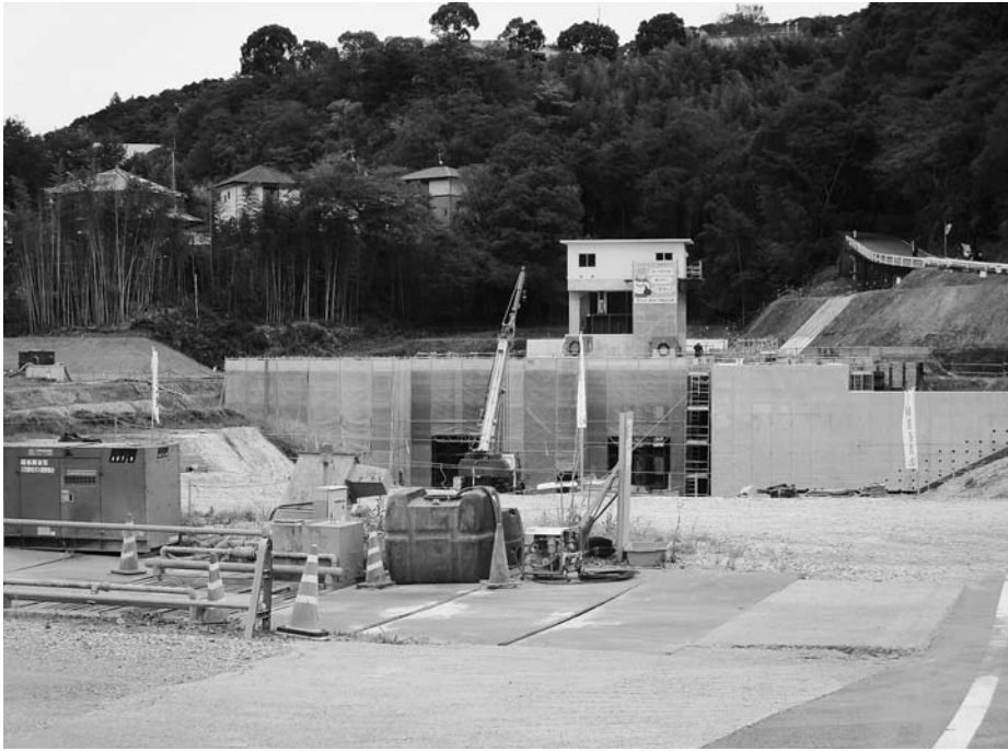
形が見えてきた新規放水路トンネル呑口
