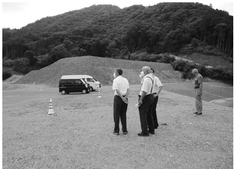
治水対策特別委員会が錦山残土処理場を視察
