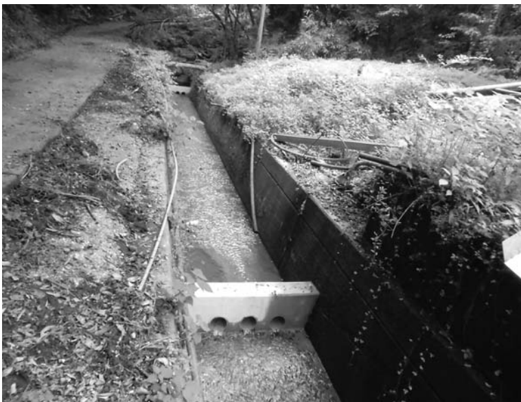
父原谷川土砂浚渫工事完成
