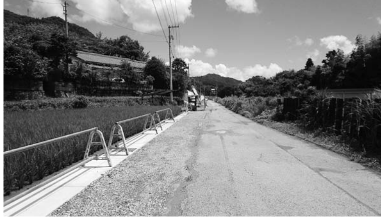
村道繁谷平野線他1路線道路改良工事 御鉢踏切付近
