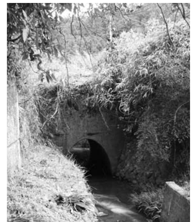
JR土讃線下 拡幅する予定の暗渠(岡端)
