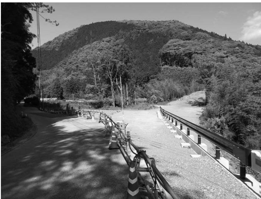
令和4年度の完成を目指す柱谷バイパス工事
