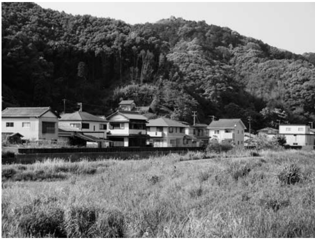
馬越南地区床上浸水対策周囲堤工事
