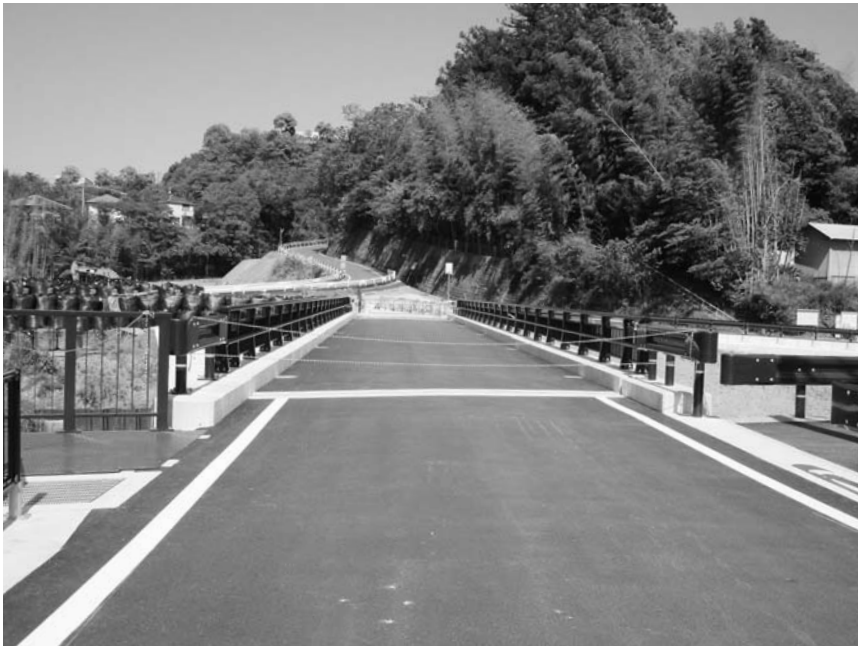
放水路橋（落合橋）付け替え工事完成
