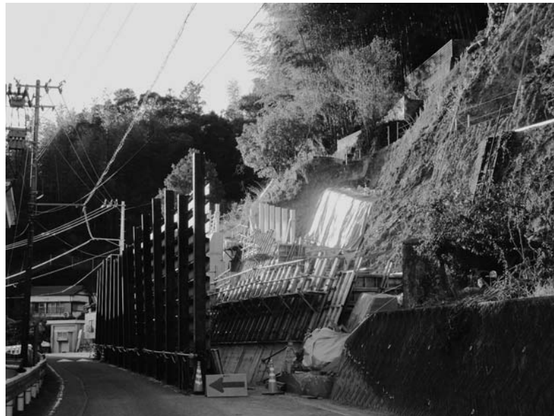
日下小学校の裏、急傾斜崩壊対策事業
