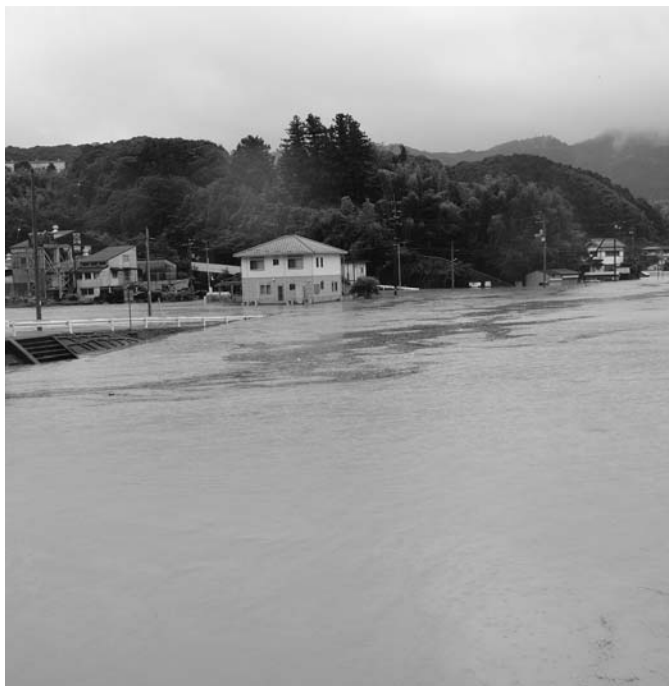
平成26年8月台風 日下川放水路呑口付近浸水状況
