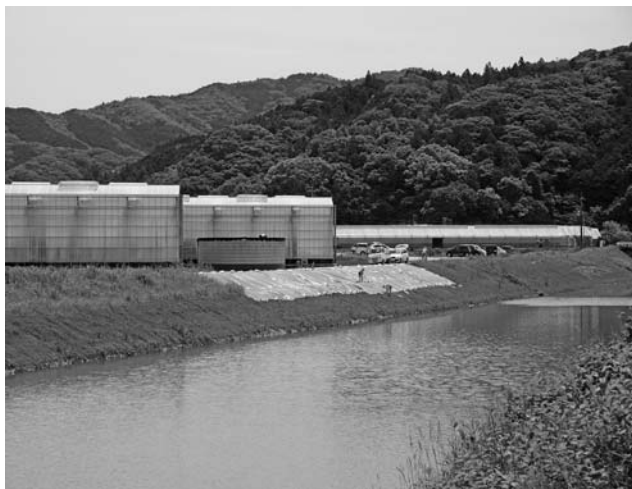
日下川護岸整備 西越橋から下流左岸応急措置
