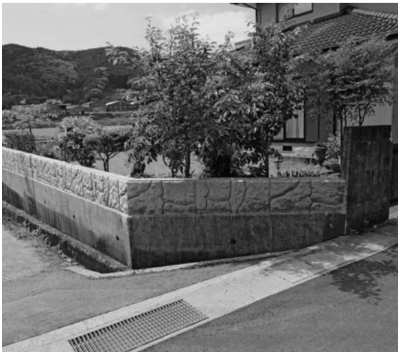
宅地擁壁嵩上げ工完成
