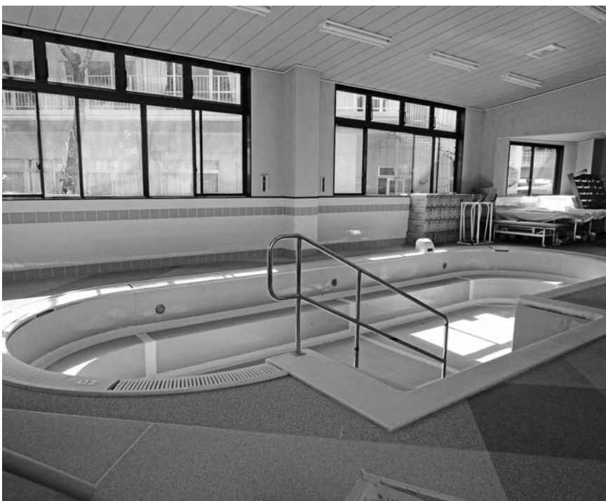
使用されていない健康センター内プール室
