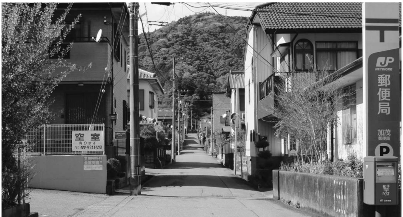
維持管理費が増すと考えられる望ヶ丘団地内道路
