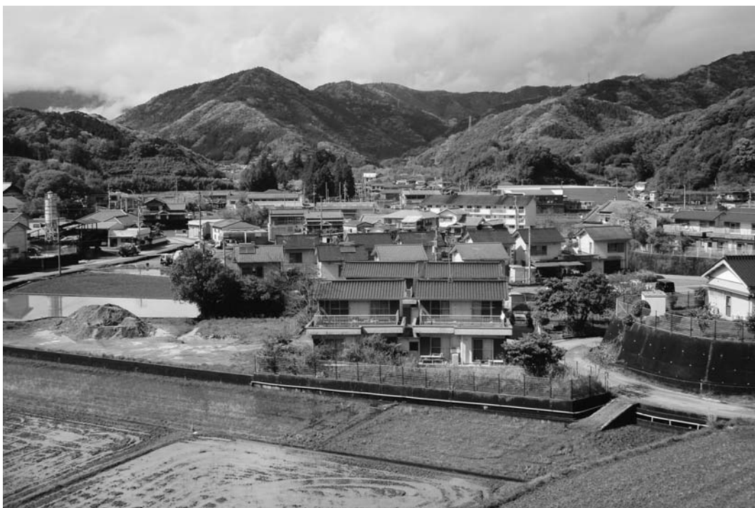
液状化を懸念される村営住宅
