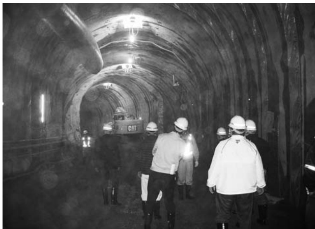
新規放水路トンネル内部を視察
