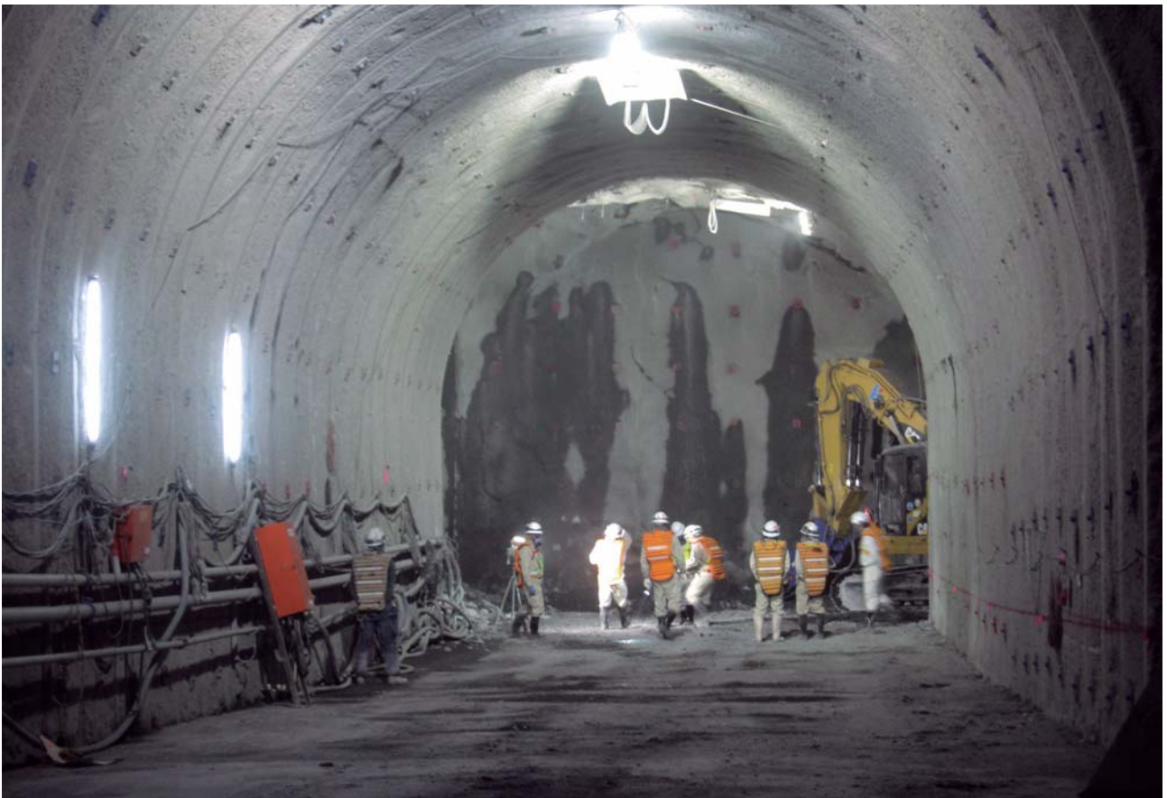
日下川新規放水路事業 トンネル本坑に到達
