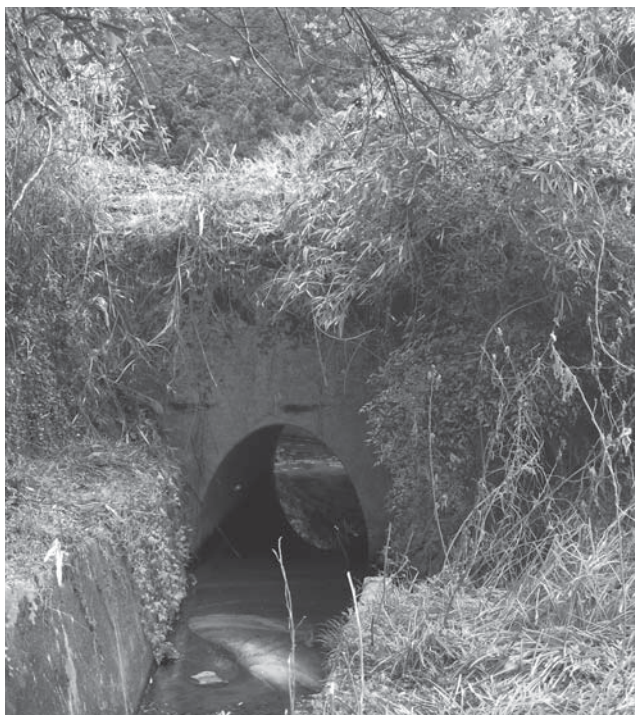
岡端地区 J R 土讃線下暗渠
