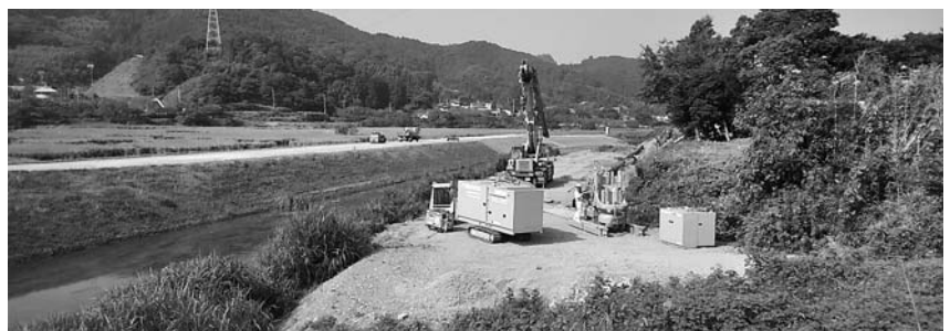
日下川改修工事
