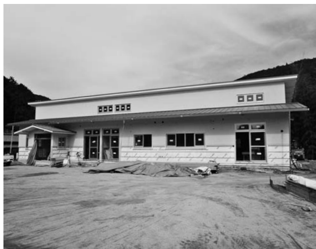
建設中の日下保育所津分園
