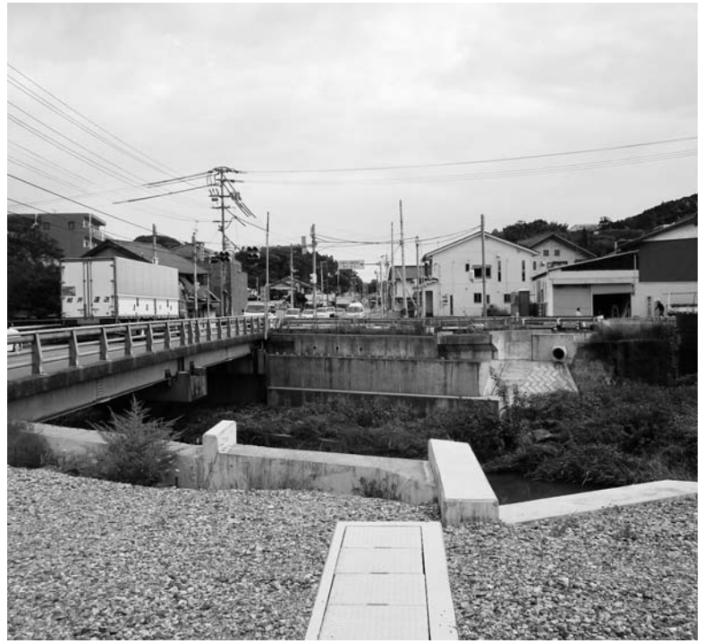
本年度架設される日下橋
