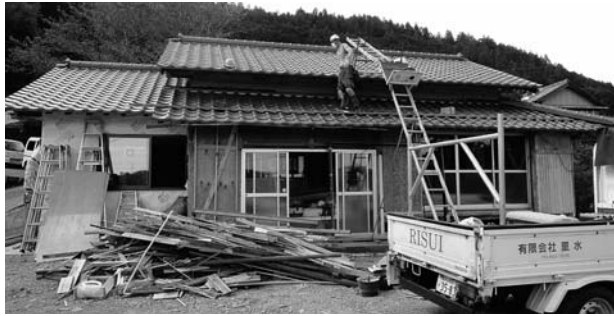
空き家改修（能津地区）
