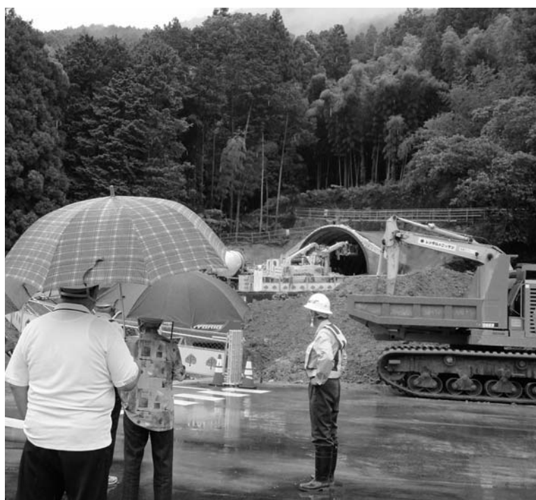
いの町大内地区吐口側工事を視察
