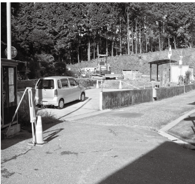
整備工事中の望ヶ丘墓地公園
