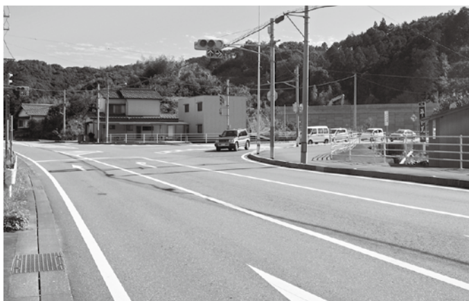
延伸・整備が進む高知西バイパス工事
