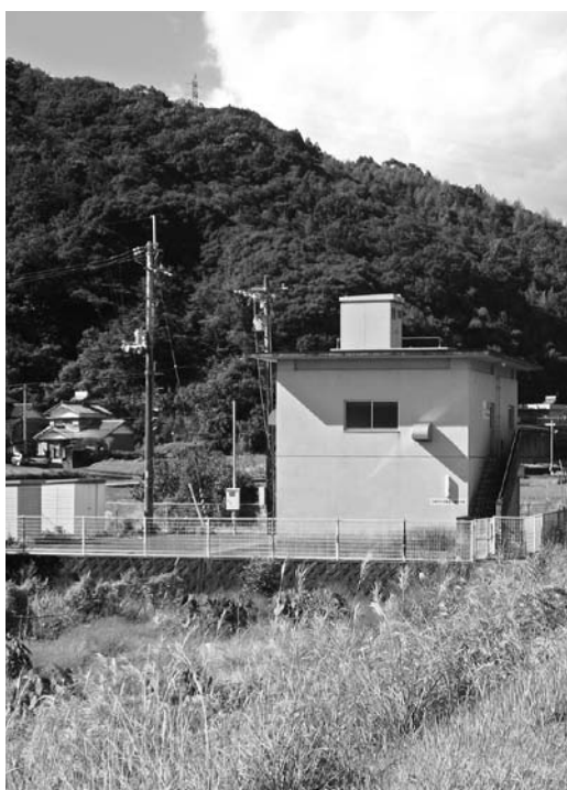
下分江尻の簡易水道管理棟
