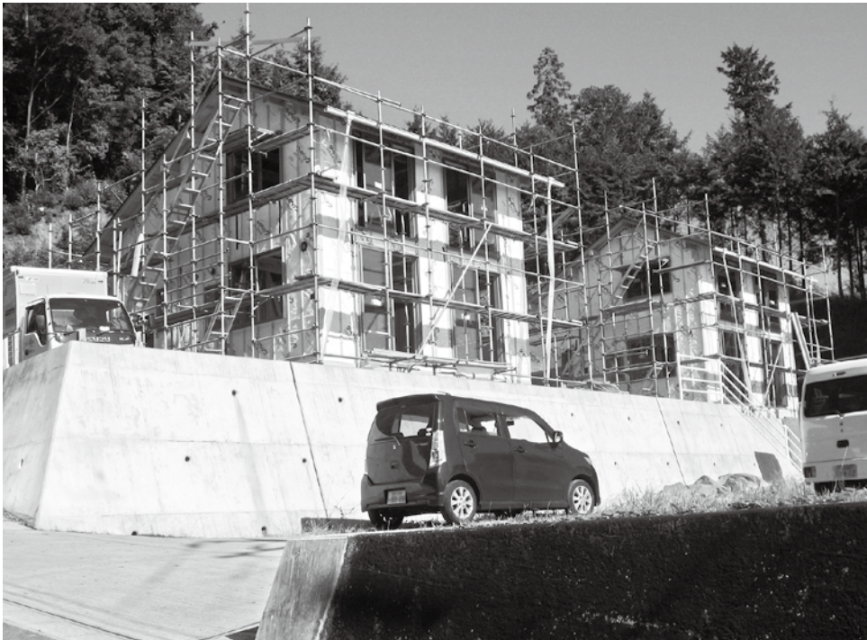
完成を待つ鍛冶屋住宅の2棟
