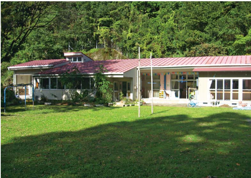
日下保育園能津分園園舎の現況
