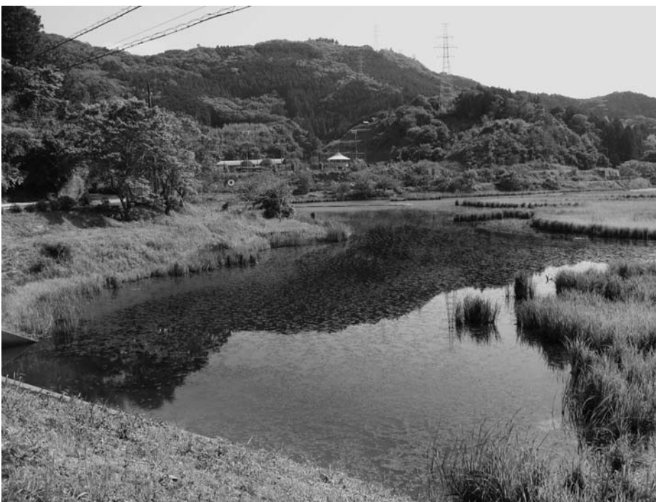
日下川調整池
