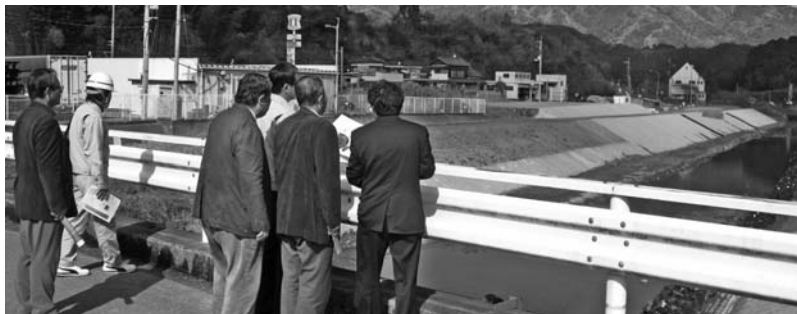
日下川護岸整備工事 鹿兒橋下流を視察
