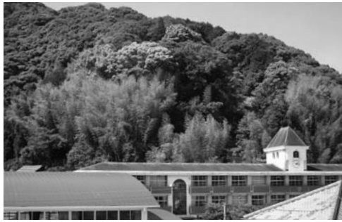
日下小学校裏急傾斜地
