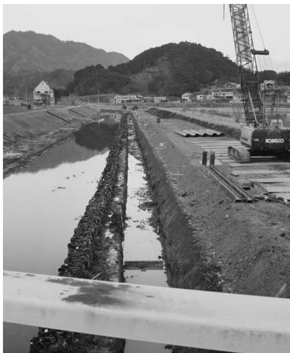
日下川床上浸水対策特別緊急整備工事 竜石付近
