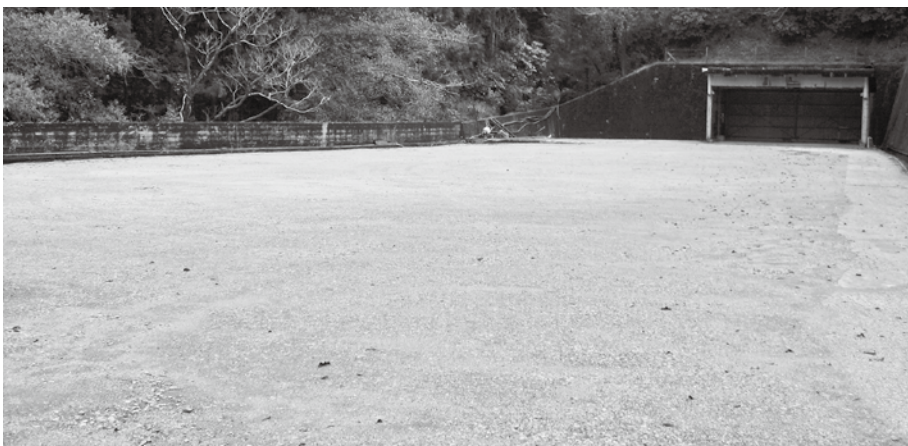
(旧) 仁淀川中央清掃事務組合清掃工場跡地
