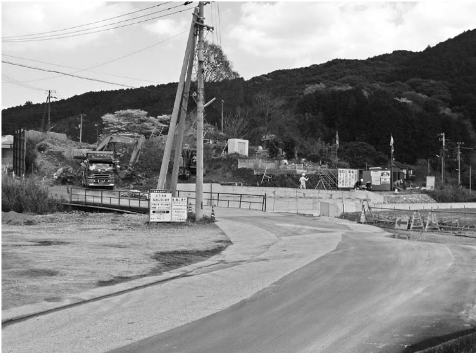
進む村道石田渋川線の工事
