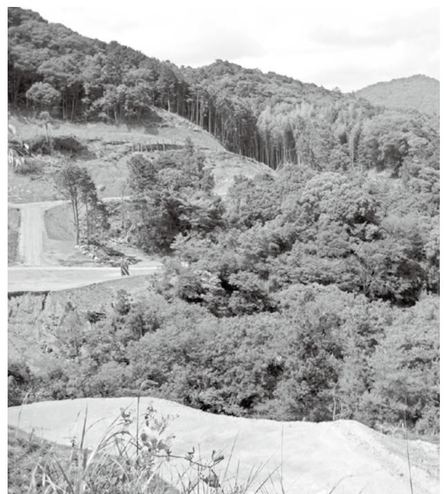
進む残土処分場整備工事
