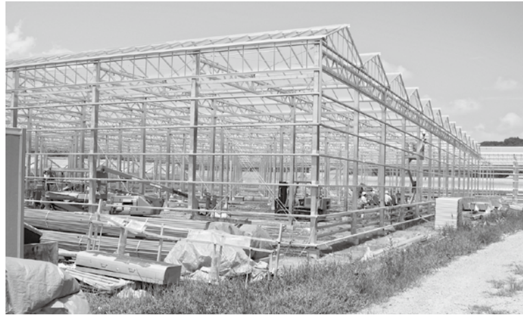
完成が近い「次世代型農業ハウス」
