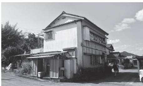
○北東側から撮影
