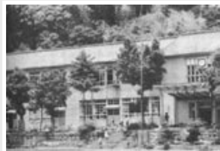
日下小学校校舎の解体始まる
