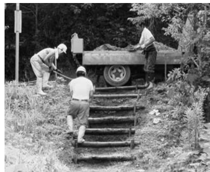
作業状況の写真
