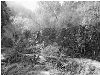
伐採作業の状況
