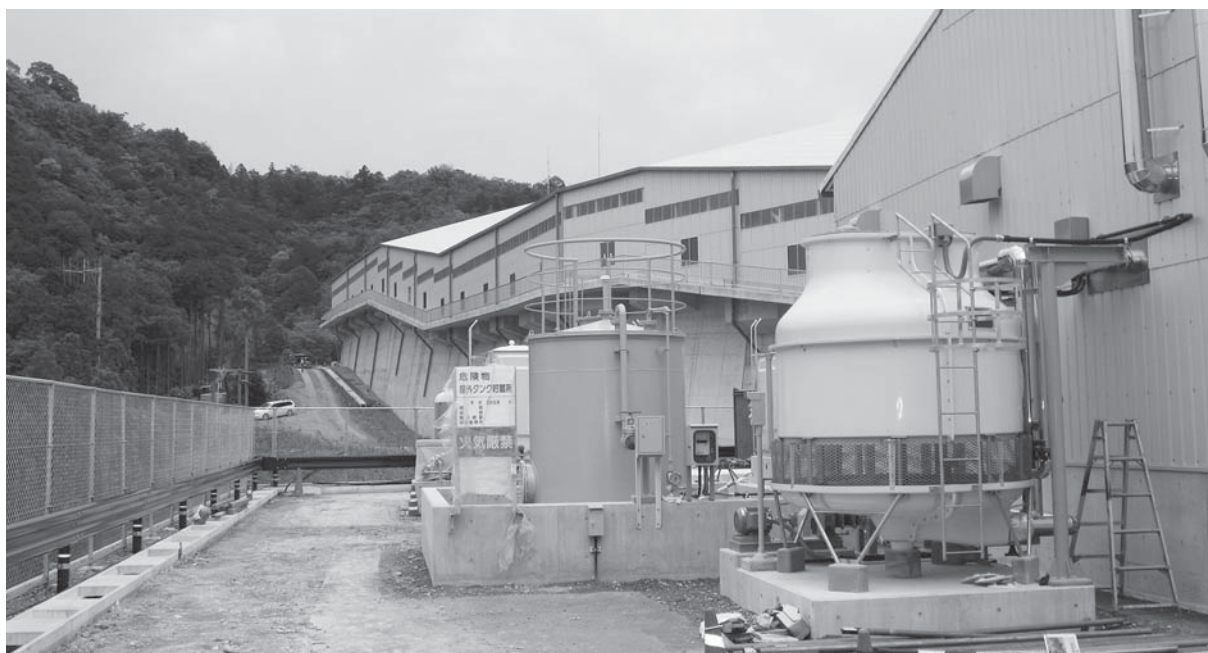
完成間近のエコサイクルセンター
