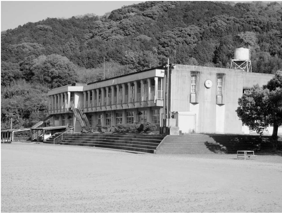
耐震診断を行う日高中
