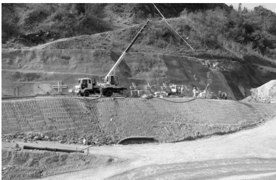
エコサイクル復旧工事
