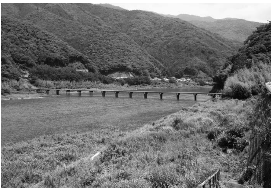
通行制限となった名越屋沈下橋
