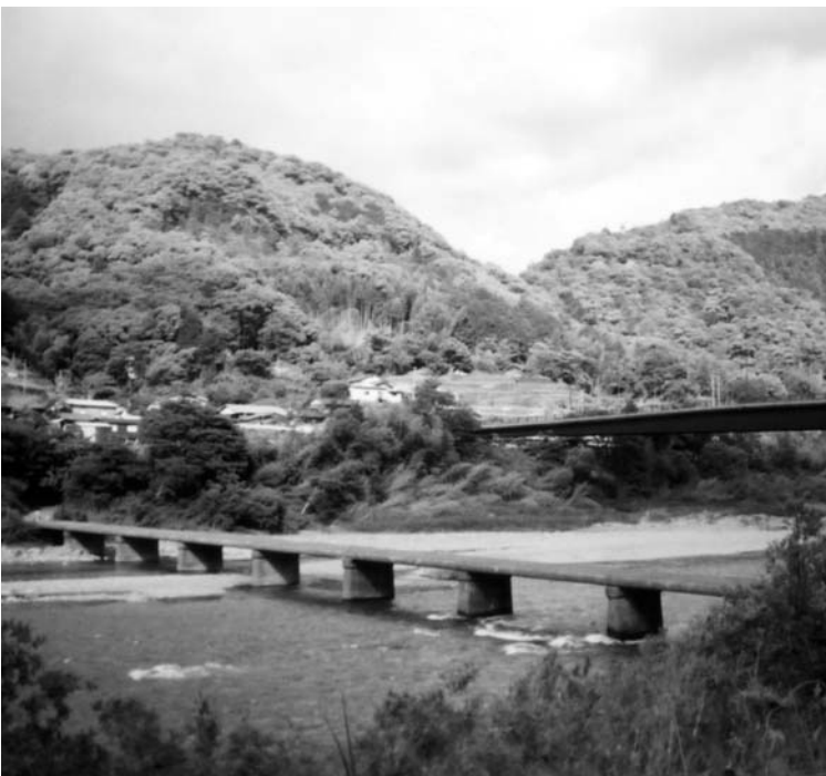
沈下橋と共存する高架橋
