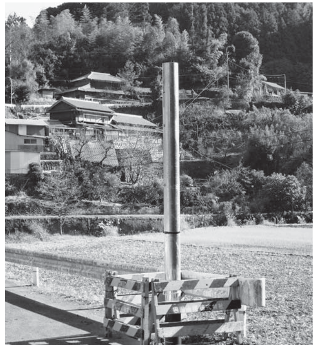
光ケーブル敷設工事
