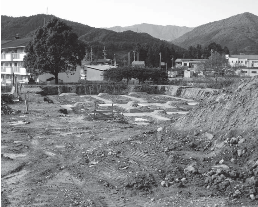
工事中の東部福祉館
