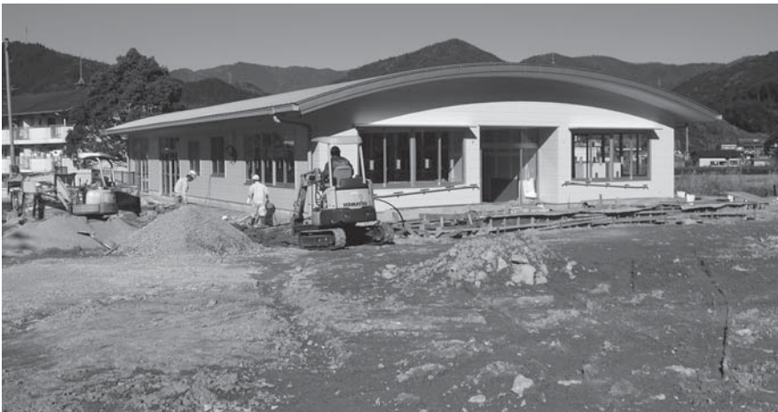
建設中の日高村下分ふれあいプラザ
