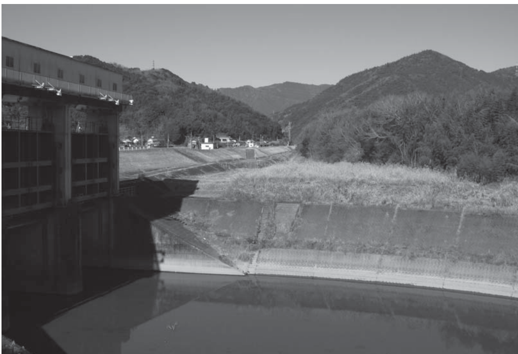
神母樋門上流部
