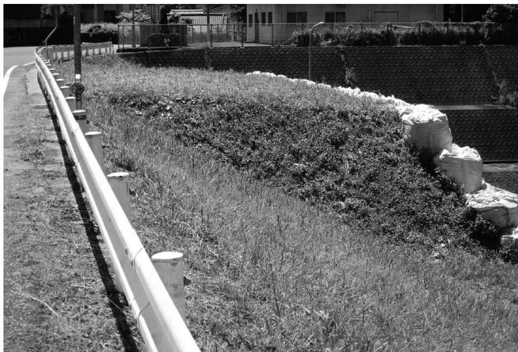
神母樋門「排水ポンプ車ヤード整備計画地」
