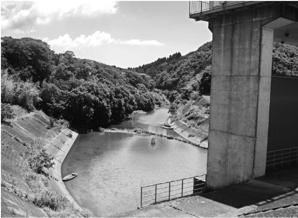
江尻・神母樋門より日下川下流域
