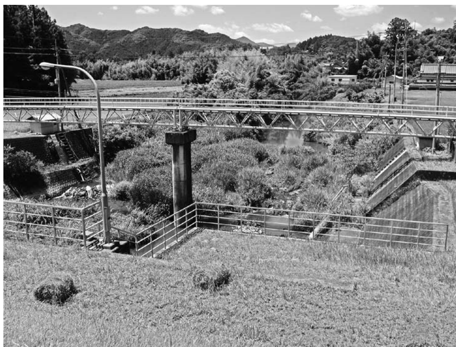
江尻・神母樋門より日下川上流域
