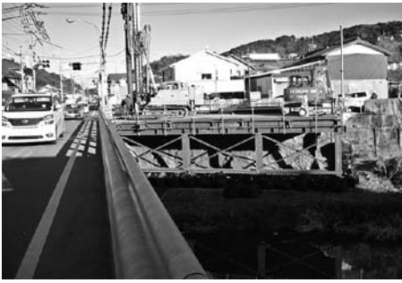
工事が進む「国道33号線日下橋付近」
