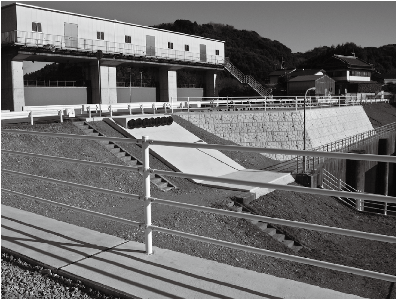
完成間近の神母樋門「ポンプ車配置ヤード整備」
