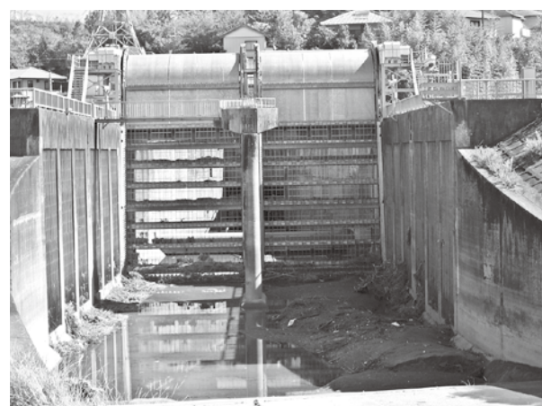
日下川放水路除塵機
