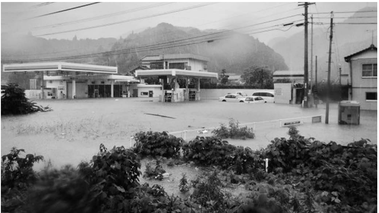
8月来襲した台風12号の被害状況(妹背入口付近)
