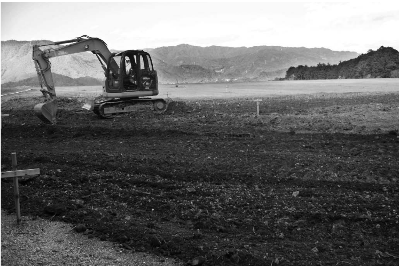
沖名残土処理場跡地に着工された太陽光発電事業工事
