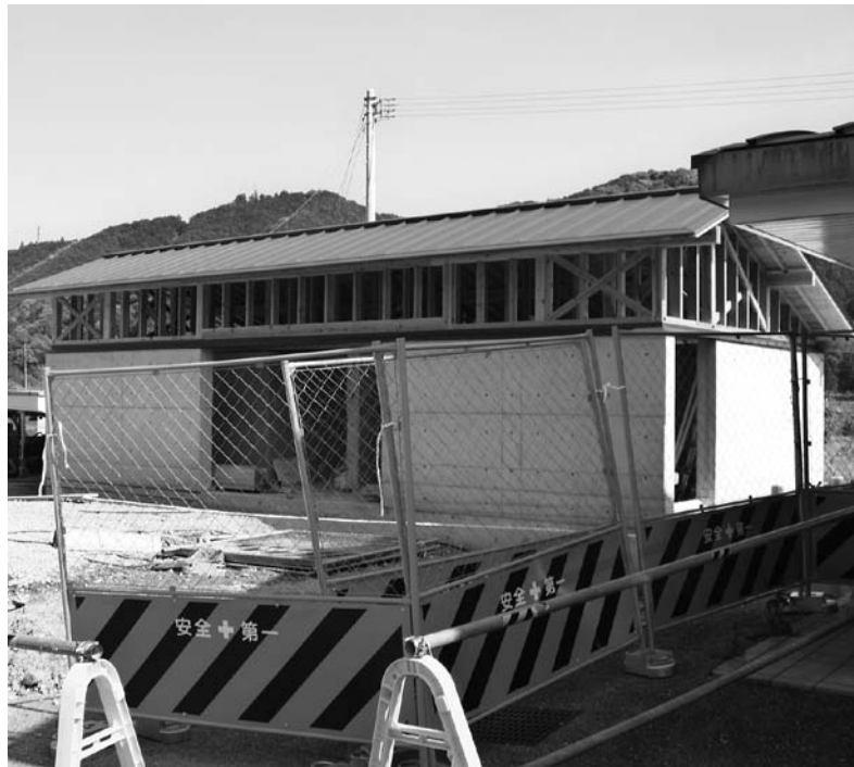
大規模改修が進む「さんさん市」付帯施設
