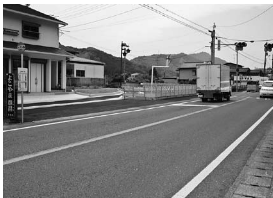
改良の進む日下橋改良工事
