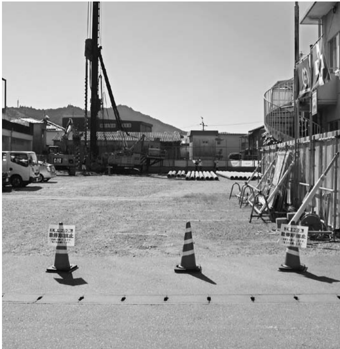
図書館建設工事
