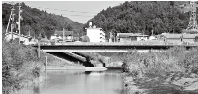
現在の日下川放水路香口付近(沖名入り口)
