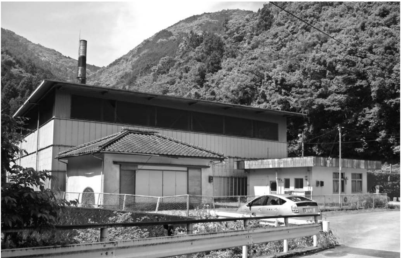
解体される(旧)仁淀川中央清掃事務組合清掃工場
