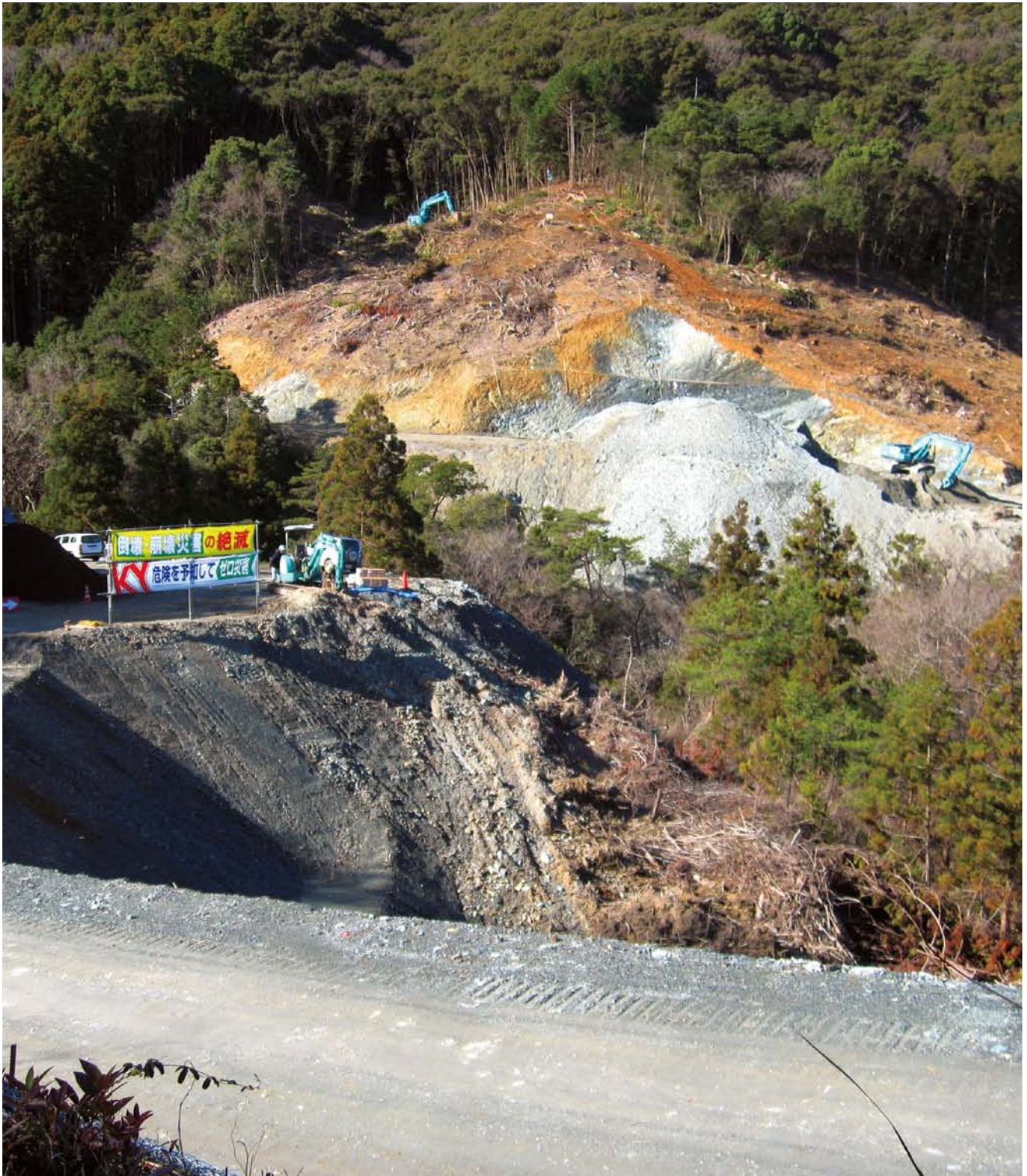
進む日下川改修工事土捨場整備工事
