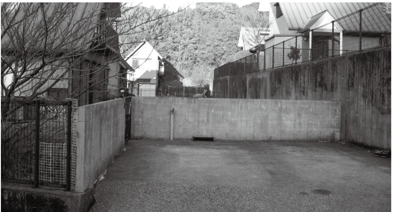
村営能津地区若者定住住宅
