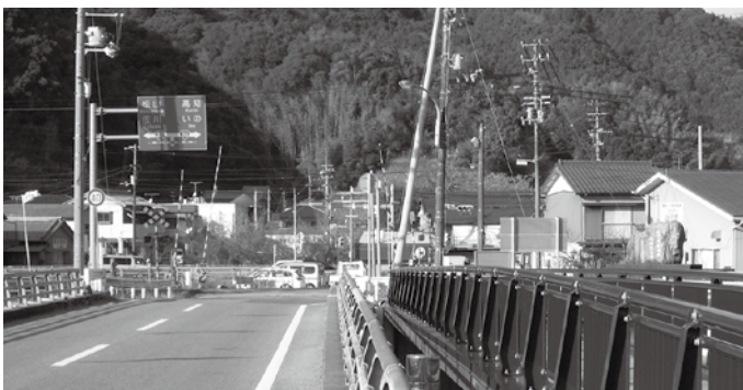
工事が進むJR沖名入り口踏切付近
