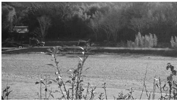
整備の進む江尻地区「かわまちづくり」事業工事
