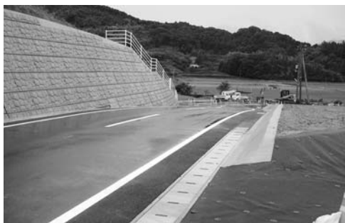
村道石田渋川線工事
