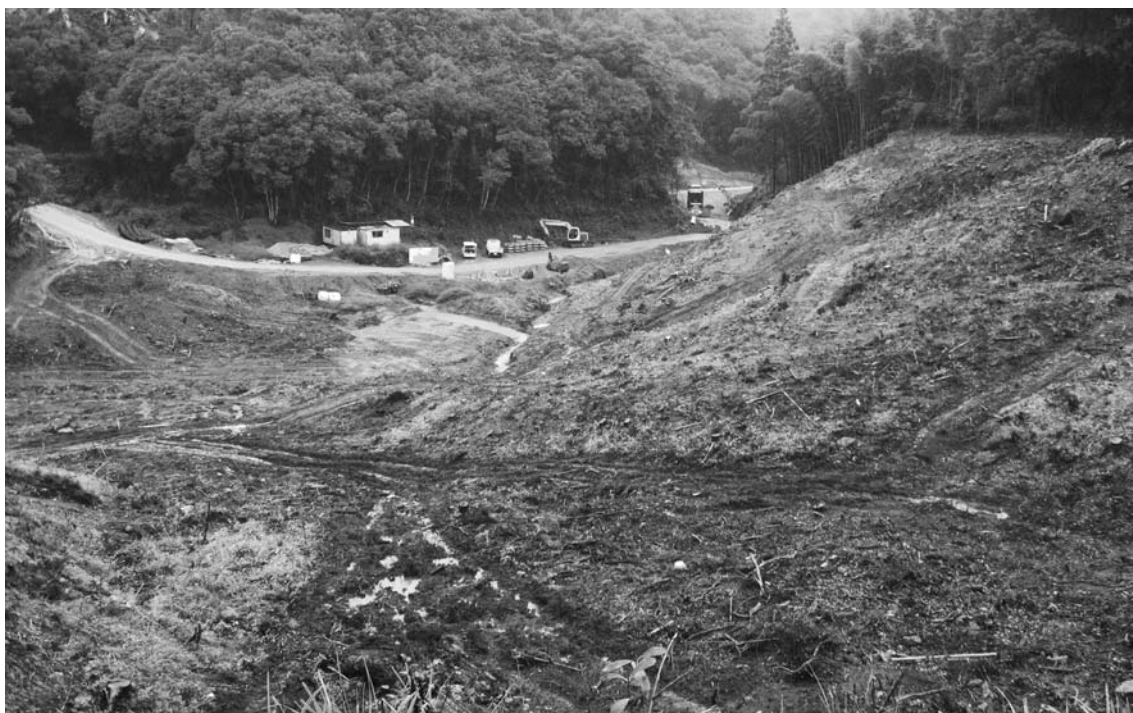
進む「日下川改修工事土捨場整備工事」
