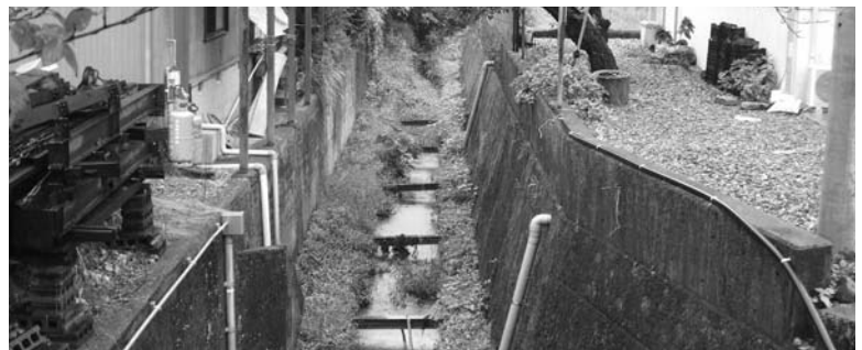
岡花地区JR線路下の暗渠
